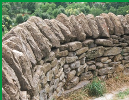
Muret en pierre sèche (détail) © Bernard Clos - Parc national des Pyrénées
